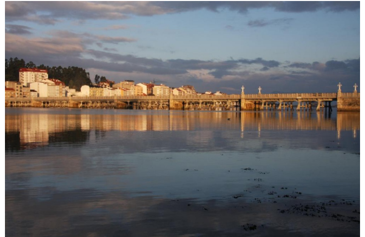
Ponte de acceso á Toxa.
